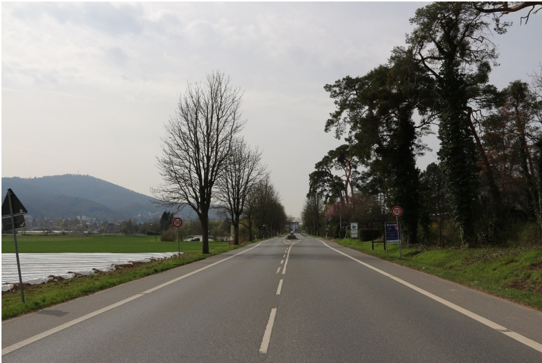
Abbildung 5: B 3 Bickenbach Ortsausgang[-eingang] (Blickrichtung Süden)
