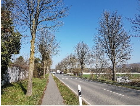
B 3 Bickenbach nördlicher Ortsausgang (Blickrichtung Norden)
